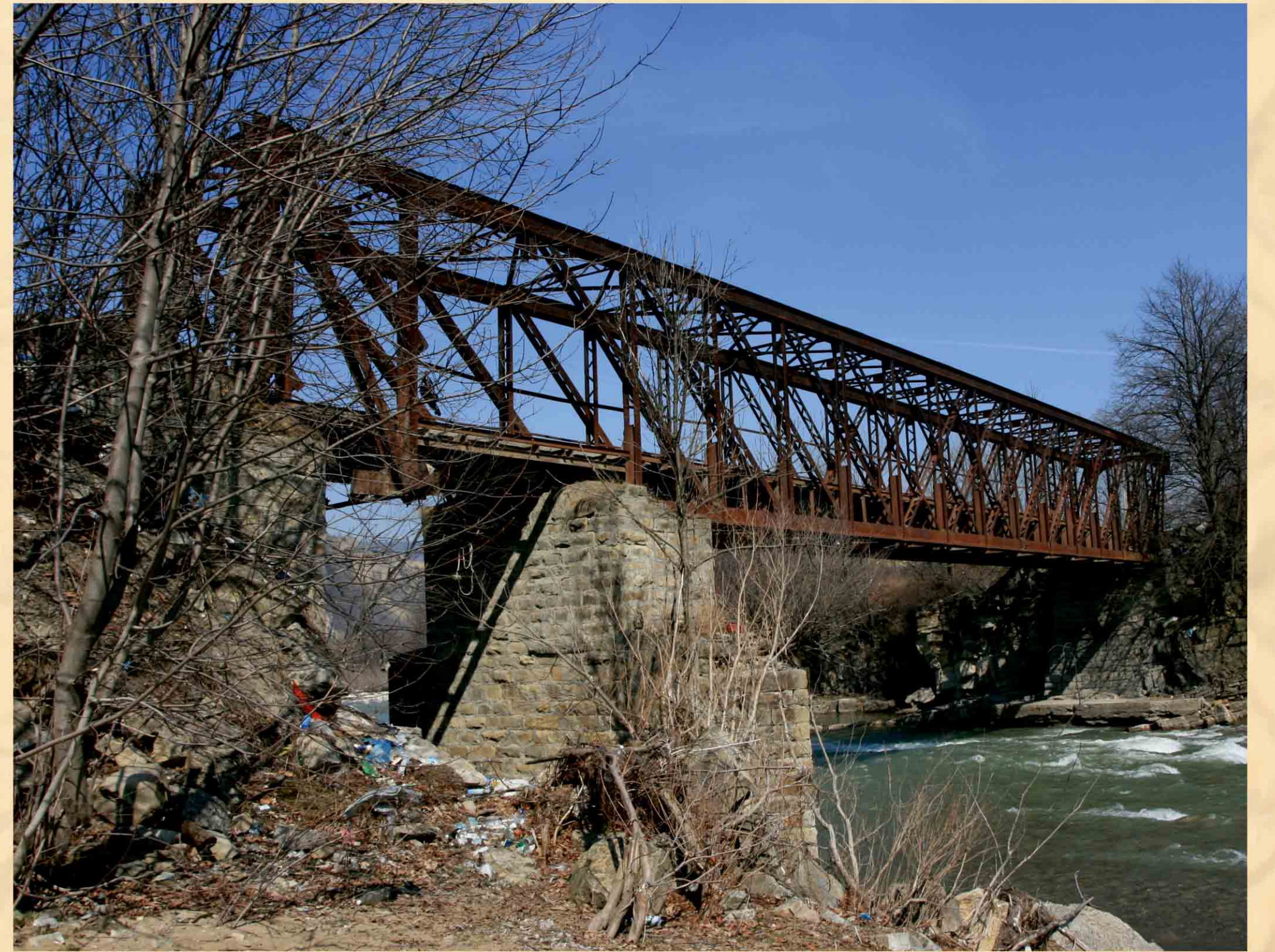
Most kratowy kolei wąskotorowej Nadwórna – Rafajłowa na Bystrzycy Nadwórniańskiej w Roztokach (za Pasieczną), stan obecny
