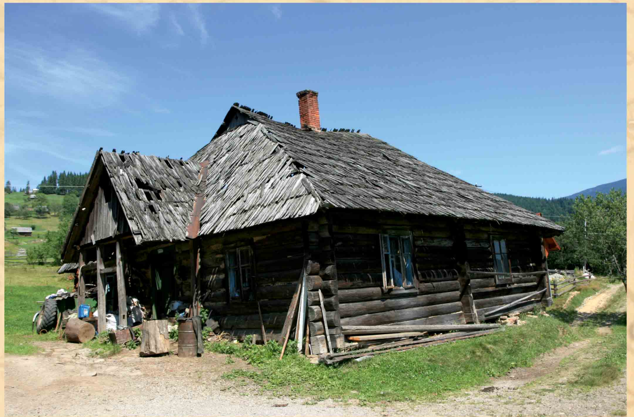
Stara chata w Rafajłowej, stan obecny
