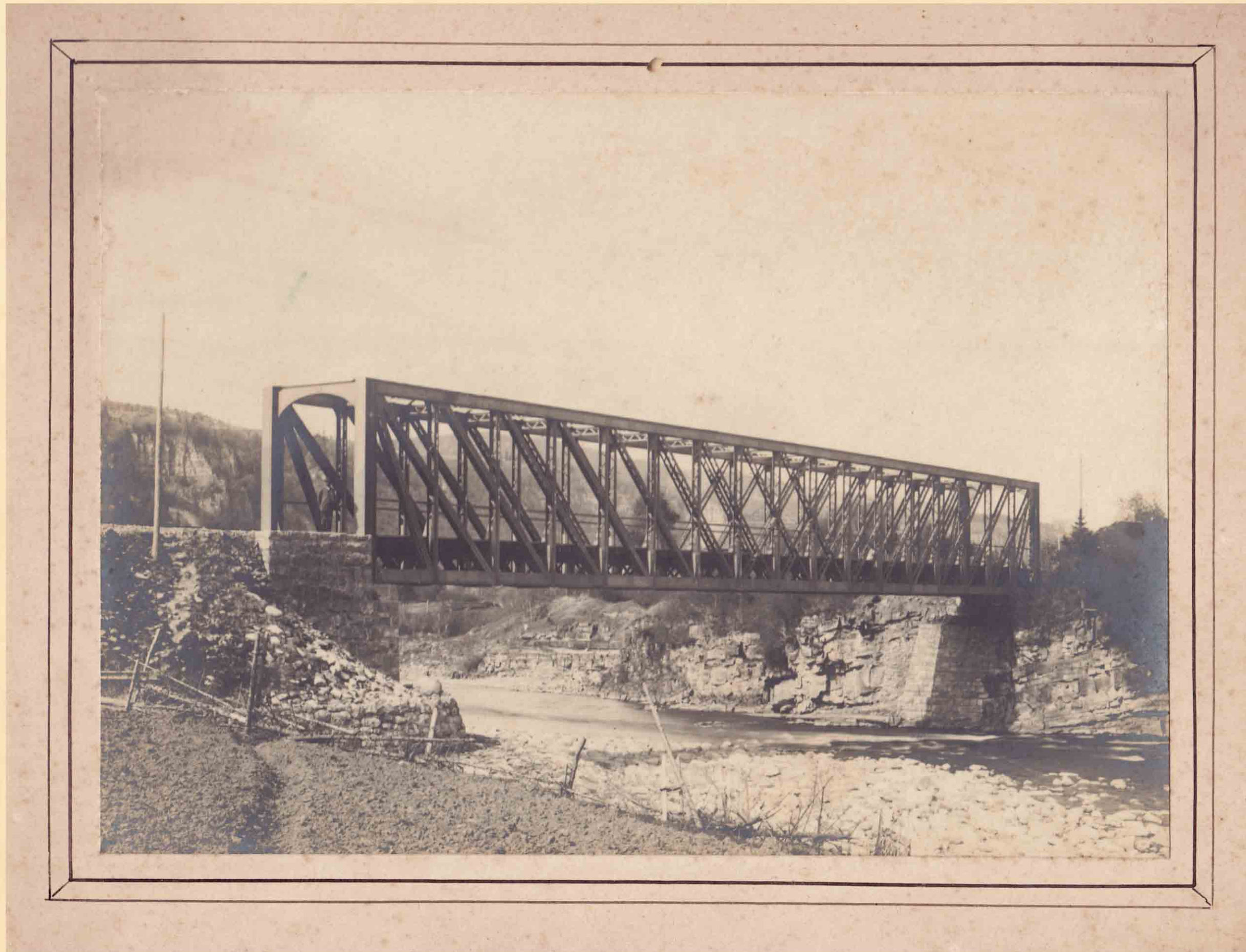
Most kratowy kolei wąskotorowej Nadwórna – Rafajłowa na Bystrzycy Nadwórniańskiej w Roztokach (za Pasieczną), fot. NN, stan przed 1914 r.
